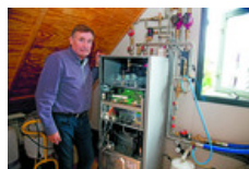
De water-water warmtepomp van Martin Wiegertjes wordt gevoed met energie die uit de buitenlucht gehaald wordt. (Foto: Fred Rotgans)
